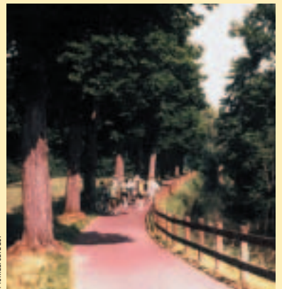
Chemin de halage transformé en voie verte (enrobé rouge) dans le Bas-Rhin avec garde-corps
