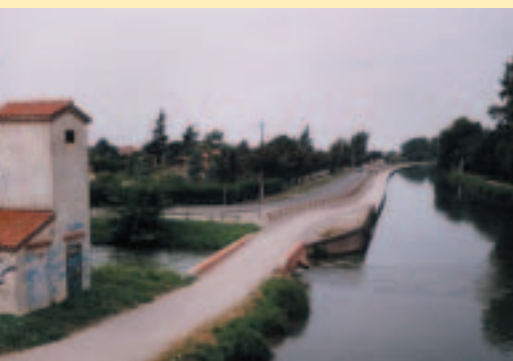
Piste cyclable-voie verte traitée en grave émulsion le long du canal latéral à la Garonne
