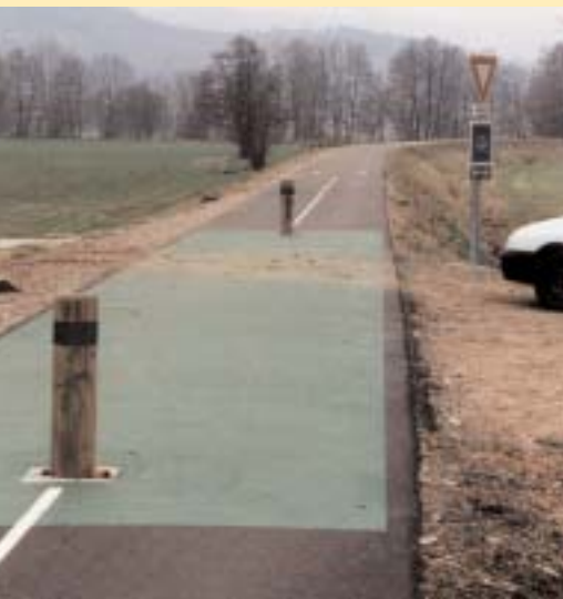
4- Une voie verte multiactivités (Vosges) avec dispositif d'alerte (potelet amovible et aplat vert) prioritaire par rapport au chemin de terre très peu fréquente qu'elle traverse
