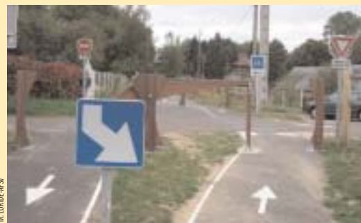
9- Îlot central pour séparation et déport des flux sur voie verte (VV) souligné de marquage blanc ; VV comportant semi-barrière pivotante, potelet amovible en bordure d'îlot et panneau Cédez-le-passage (cf. cas 2 et 4 et illustration 13)
