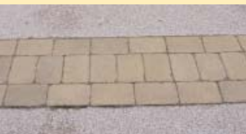
6- Dispositif d'alerte sur VR avant intersection
