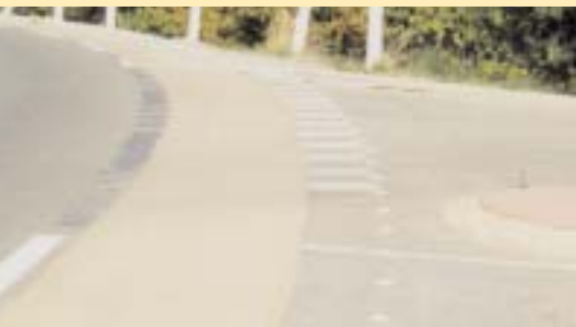
15- Cas n° 6: cas existant mais à éviter: VR sous forme de bande cyclable sur route principale croisant une route à faible trafic; la bande/VR suit, selon le Code de la route, le même régime de priorité que la voie sur laquelle elle est implantée (ici elle est prioritaire, on trouve donc un panneau Cédez-le-passage sur la voie secondaire avec îlot placé en retrait
